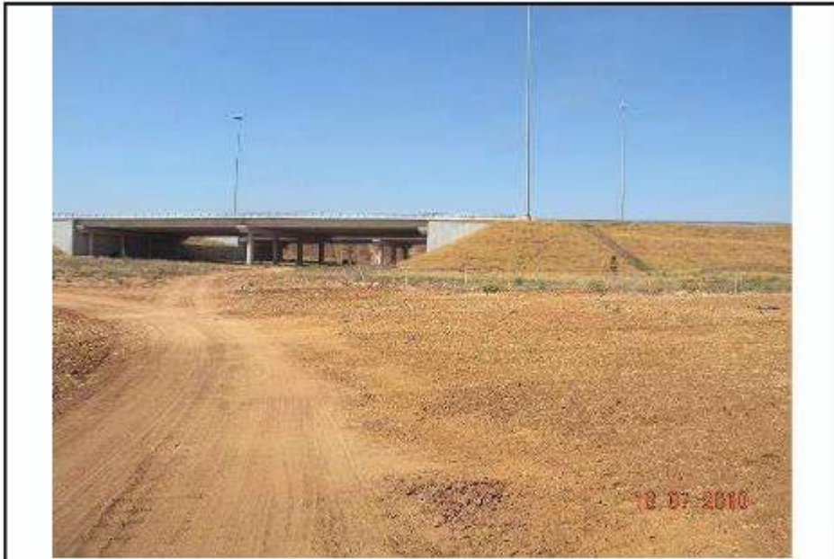
תמונה מס' 3: תוואי כביש 200 מתחת לכביש 431
